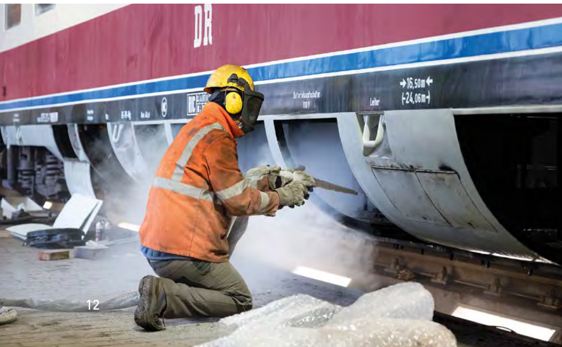
Reinigung der Batteriekästen
